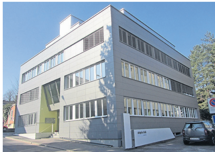
... und nach der zeitgemässen Totalsanierung.
