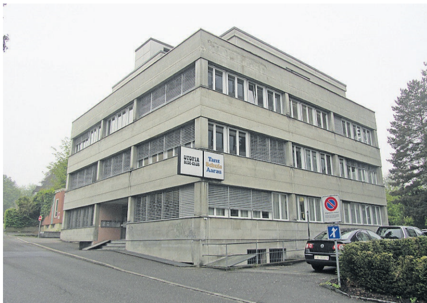
Liegenschaft vor der Renovation ...
