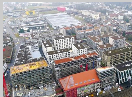
Überbauung „ImLenz“, Lenzburg; www.imlenz.ch
