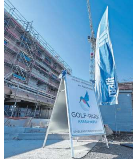
Am 3. Dezember 2024 war Spatenstich – 16 Monate später wurde Aufrichte gefeiert.
