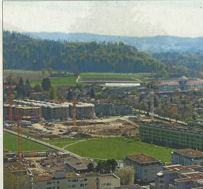
Die Widmi in Lenzburg mit dem Widmipark.
