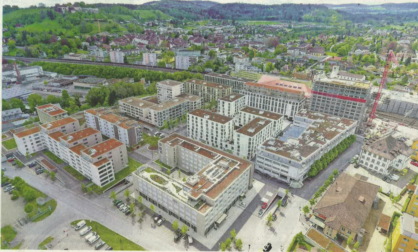
«Im Lenz» aus der Luft: Zehn von zwölf Gebäuden sind fertig, gebaut wird jetzt noch «Im Fokus» und «Im Puls» an der westlichen Ecke in Richtung Bahnhof (oben rechts).
